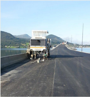
Figur 2. Gjutning av betongräcke i Norge 2015, NCC Profilbetong.
